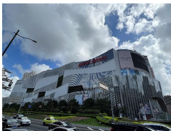
项目外观-西侧
