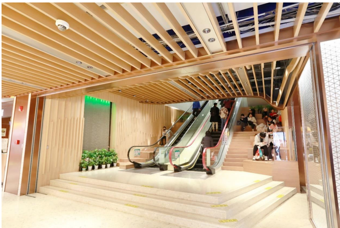
B1小食街及超市入口装饰调整工程
